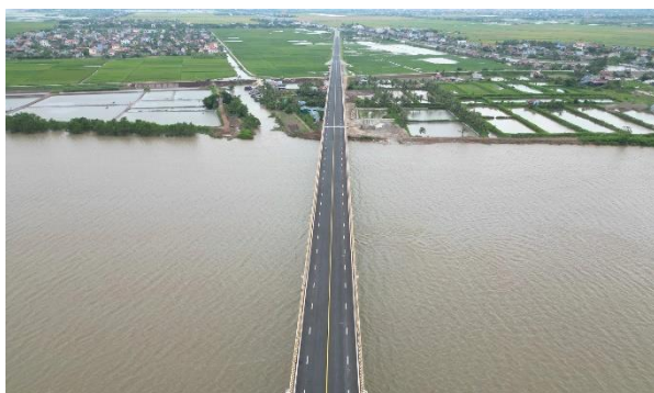
Cầu vượt sông Đáy
